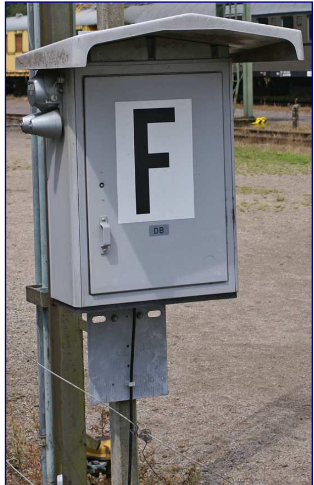
Eines der fehlenden Accessoires für die Trassengestaltung ist ein Streckenfernsprecher der DB-Bauart.
