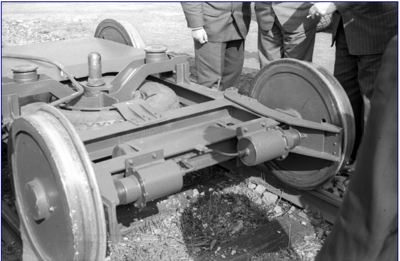
Hier wird, laut Aufzeichnungen im Mai 1954 in Dürrstadt, das auf einem Krauss-Maffei-Bus basierende Exemplar mit dem Besatzungskennzeichen AB 06-5410 aufgelegt (Bild oben). Der Blick auf den Spurwagen zeigt auch die Bremszylinder samt Zuleitungen (Bild unten). Fotos: A. Dormann, Slg. W. Löckel (Eisenbahnstiftung)
