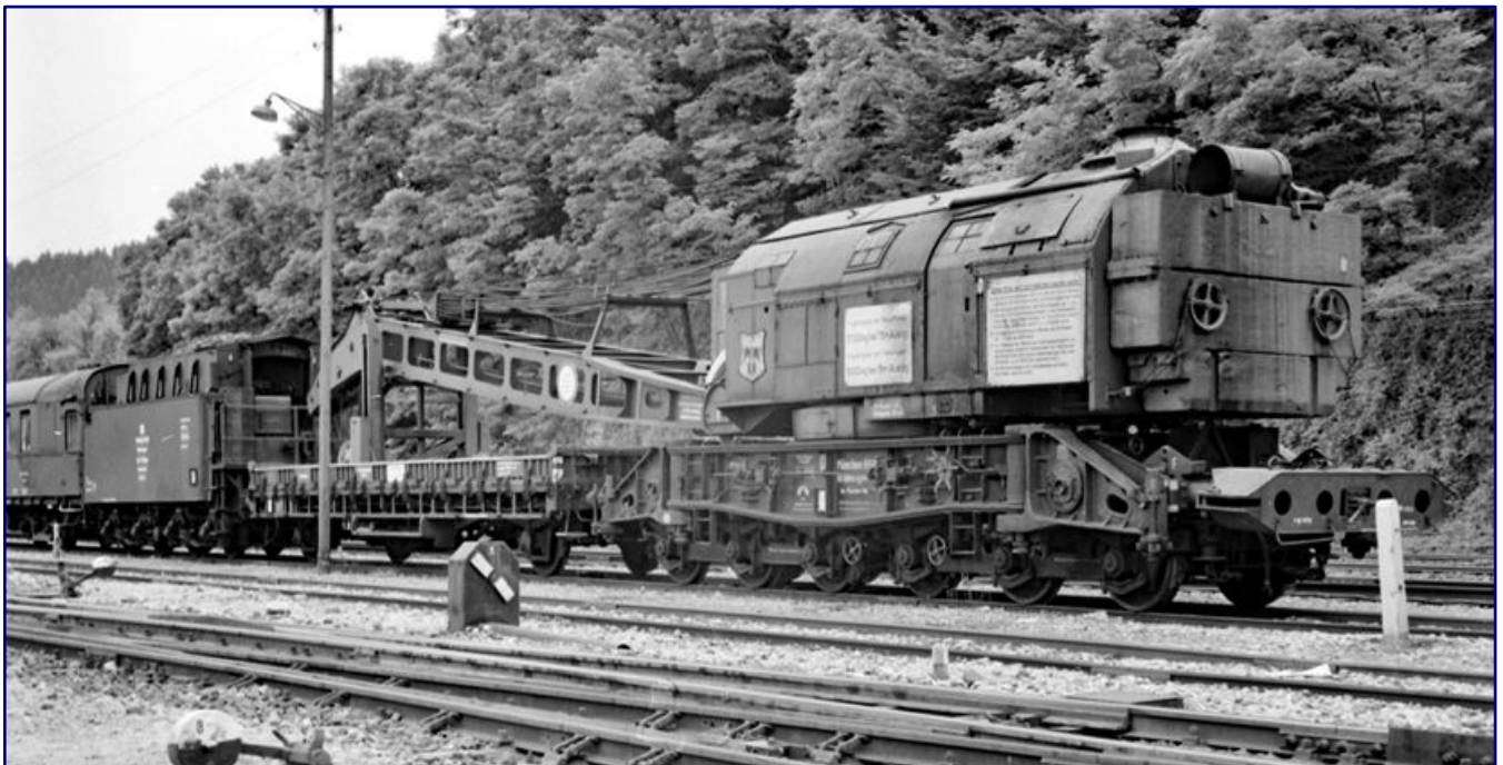
Am 13. Juli 1968 steht der 57-t-Kran „München 6664“ im Bahnhof Gaildorf-West, um Brückenteile an der Kocherbrücke auszutauschen. Im Bild zu sehen sind auch der versorgende Tender 2'2' T 34 und der Aufenthaltswagen fürs Kranpersonal – ein ehemaliger „Hechtwagen“. Foto: Wolf Schneider, Slg. Eisenbahnstiftung
