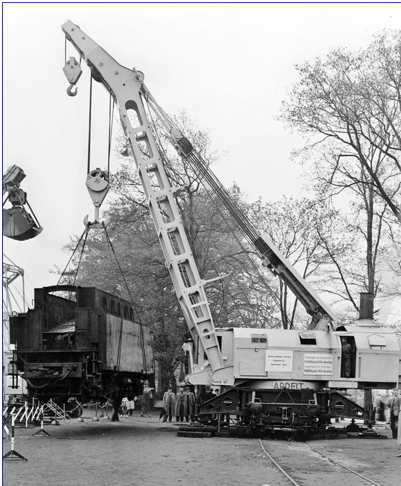
1957 gehörten die 57-Tonnen-Kräne von Ardeit noch zu den modernsten Hebewerkzeugen, die die Bundesbahn zu bieten hatte. So wird im Rahmen einer Messevorführung an einem Tender die Leistungsfähigkeit des offenbar goldgelb lackierten Schienenkrans vorgeführt. Dies geschieht bei geringer Ausladung, aber maximaler Abstützung. Interessant für die heute vorzustellende Modellumsetzung ist die Schichtung der Bauswellen, auf denen die Stempel der Stützen ruhen. Foto: Slg. Eisenbahnstiftung.
