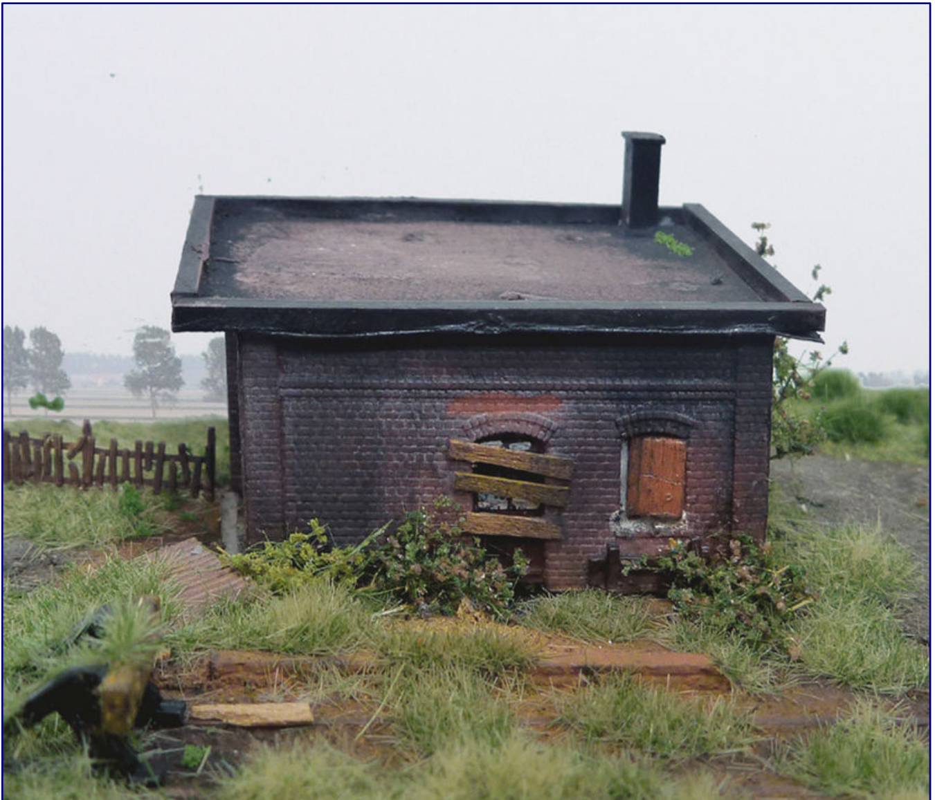
Der kleine und vernagelte Bau gehörte am Endbahnhof „Helenensiel“ jahrzehntelang zum Dampflokbetriebswerk. Ein Stück Gleis und der Prellbock sind noch vorhanden.
